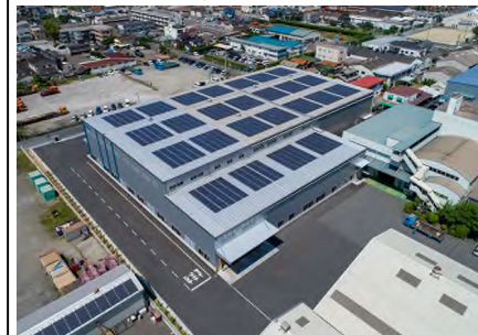
屋根全面に設置された太陽光パネル
